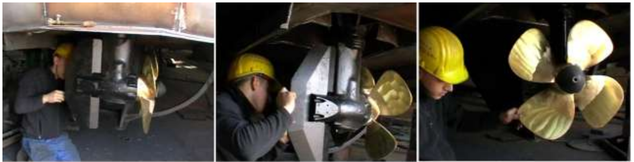
Einbau des Ruderpropellers, April 2012
